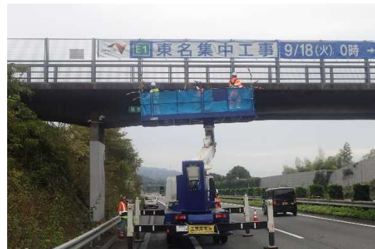
【跨道橋の点検】
